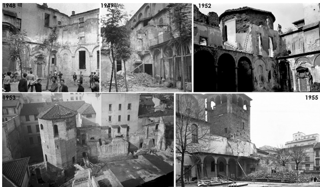
Fig.2 Foto d'epoca scattate tra il 1948 ed il 1955: è possibile vedere come le torri fossero inglobate nella struttura del monastero (foto 1948 e 1949) e come in solo in seguito alle demolizioni dell'immediato dopoguerra (1952) siano state riportate alla luce (1953,1955).
